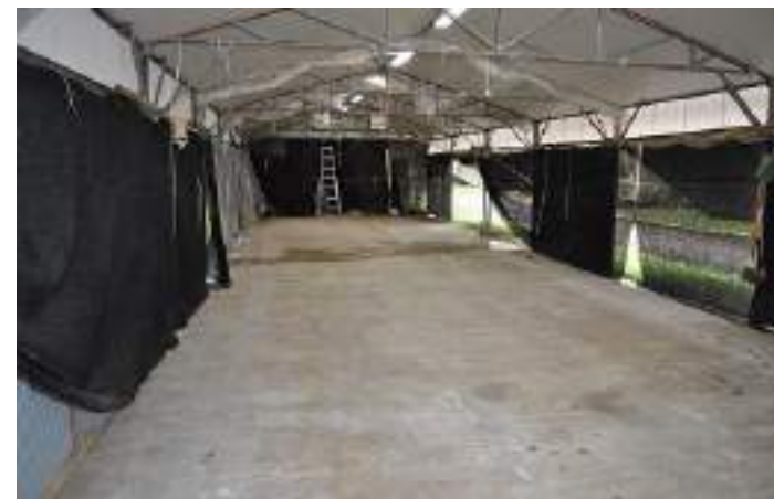
飼育台の解体作業終了
