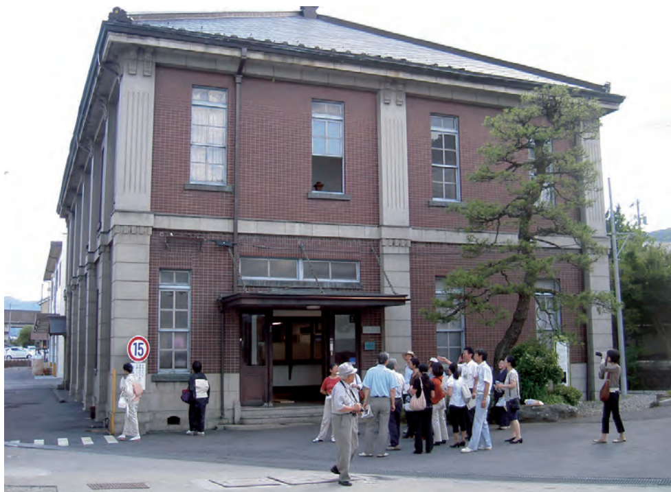
写真5 見学会 片倉組垣外製糸事務所外観
