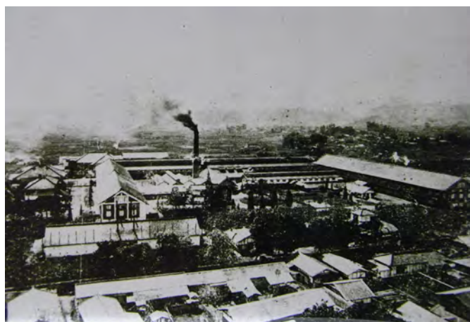
(写真 14) 富岡製糸場 「大日本蚕業家名鑑 全」(大正7年再版)より引用
