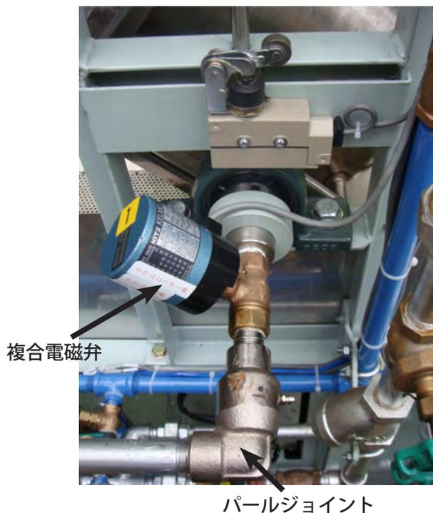
図2 パールジョイントと複合電磁弁
