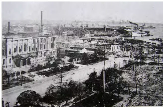
写真 22 神奈川県庁周辺の被害 （出典：神奈川県震災誌から引用）
