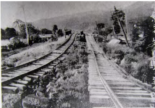
写真 24 鉄道被害（東海道線） (出典：神奈川県震災誌から引用)
