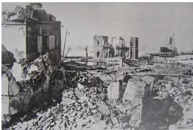
写真 21 横浜大橋の被害 （出典：神奈川県震災誌から引用）
