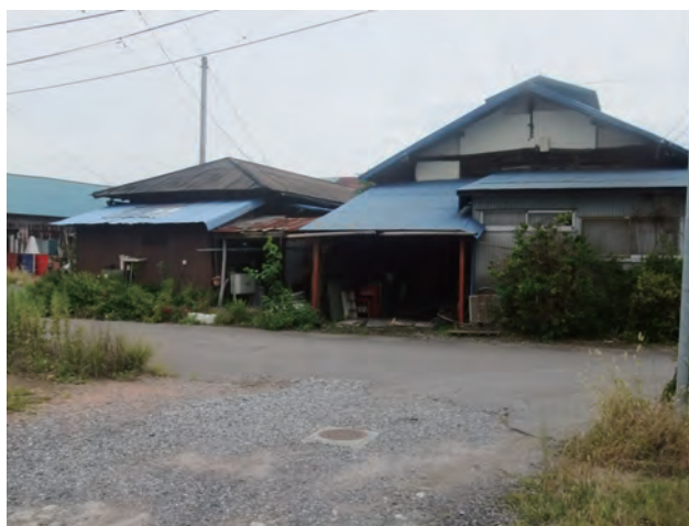
「前面が道路、遠景に古い建物」 往時の隆盛が偲ばれる「岡谷館」の一部
