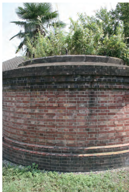
写真 3：「カネボウの大煙突」として親しまれた煙突の基礎部分
