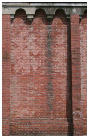
写真2：倉庫の外壁部分—上部にはイタリア風の装飾「ロンバルト帯（小アーチ）」が施されている。
