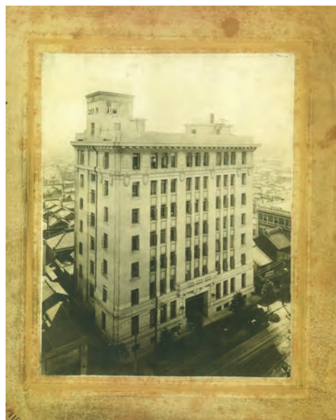
写真2：片倉館二期工事完成写真
