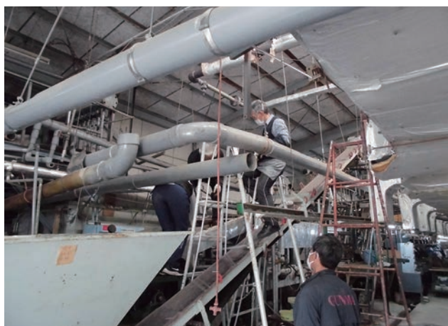
工場内の配管等の整備
