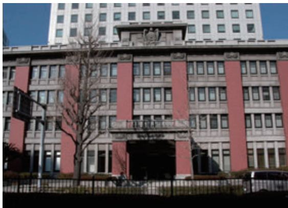
図1 横浜第二合同庁舎
